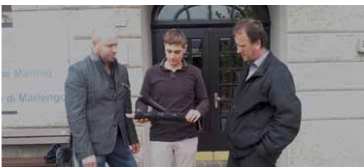
Markus Gufler spiega i dettagli tecnici per la posa dei cavi in fibre ottiche
